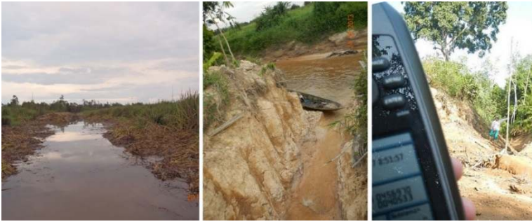
Gambar 4.3. Parit-parit yang mengalirkan air rawa langsung ke Sungai
